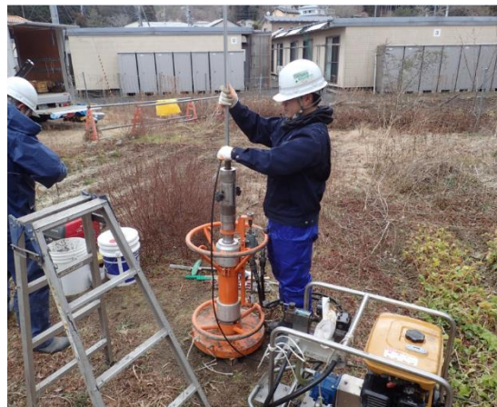
引き抜き装置による埋設ロッド回収作業
