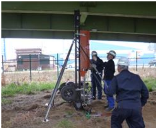
動的貫入試験機による地中設置作業
